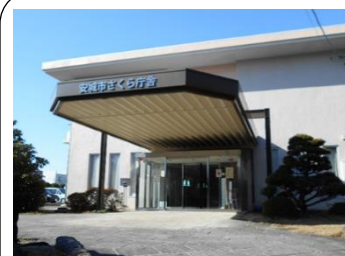
安城市では、被災時は安城市役所さくら庁舎が災害ボランティアセンターの設置予定場所になっています。
